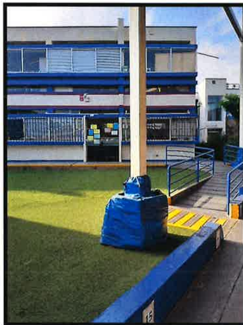
Fig. 03 – Columnas en buen estado
